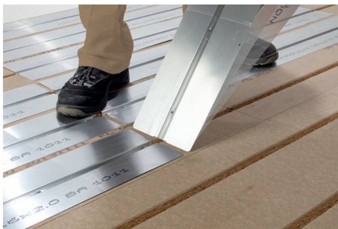
Figur 9 Värmefördelningsplattorna kan monteras stående.
