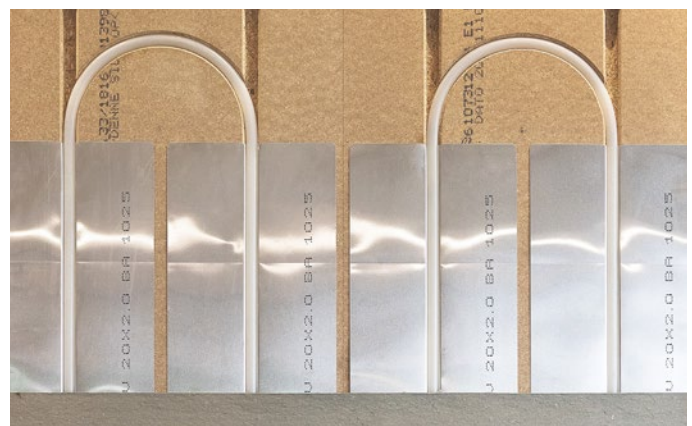
Figur 3 Värmefördelningsplattor till 16 mm värmerör, spåravstånd cc. 200 mm.
